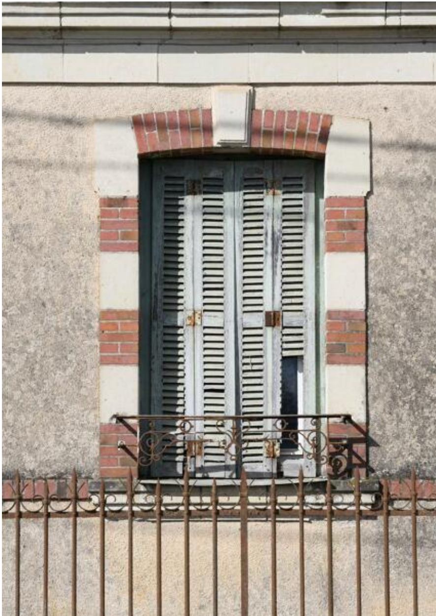
Détail d'une fenêtre.
