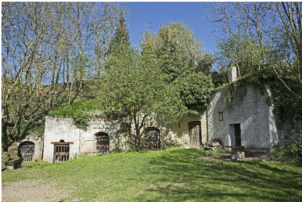
Cavier de Saint-Amadou, Ruillé-sur-Loir : faces nord et est.
