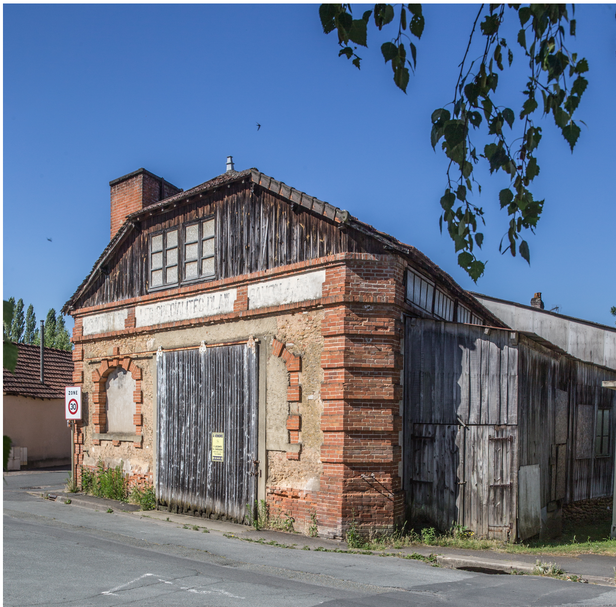
Le pignon de l'ancienne usine.
