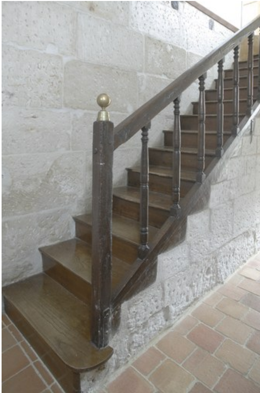
Escalier principal, à marches en pierre recouvertes en bois.
