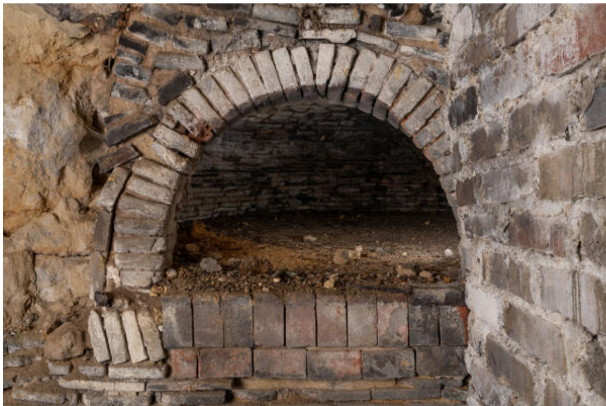
Atelier troglodytique, intérieur : bouche d'entrée du four à pain.
