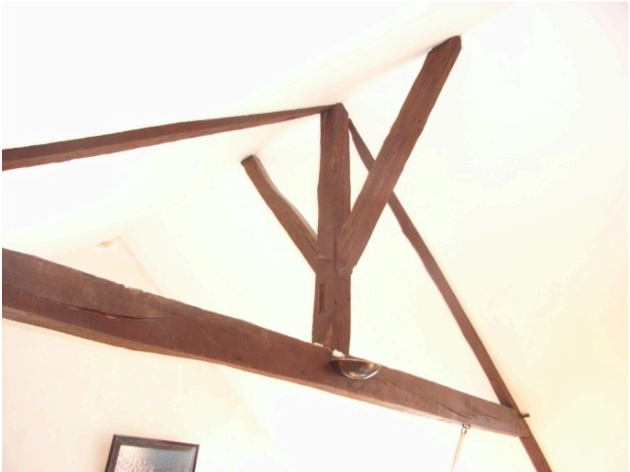
Détail de charpente de la partie sur rue.
