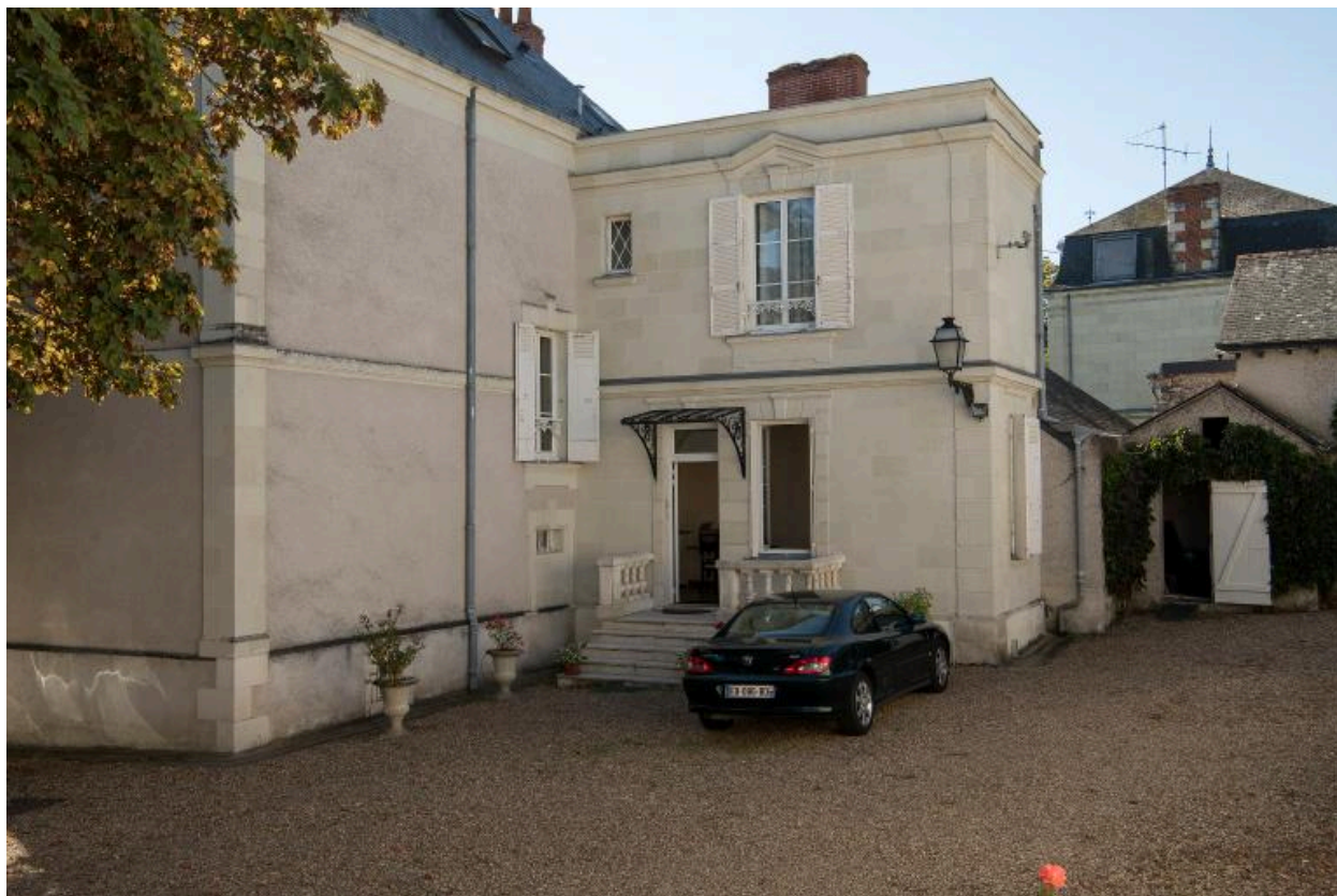
Vue de la façade sur la cour.
