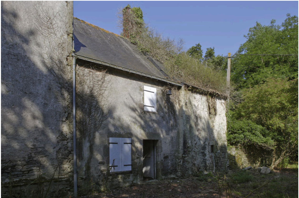
Aile sud. Façade ouest.
