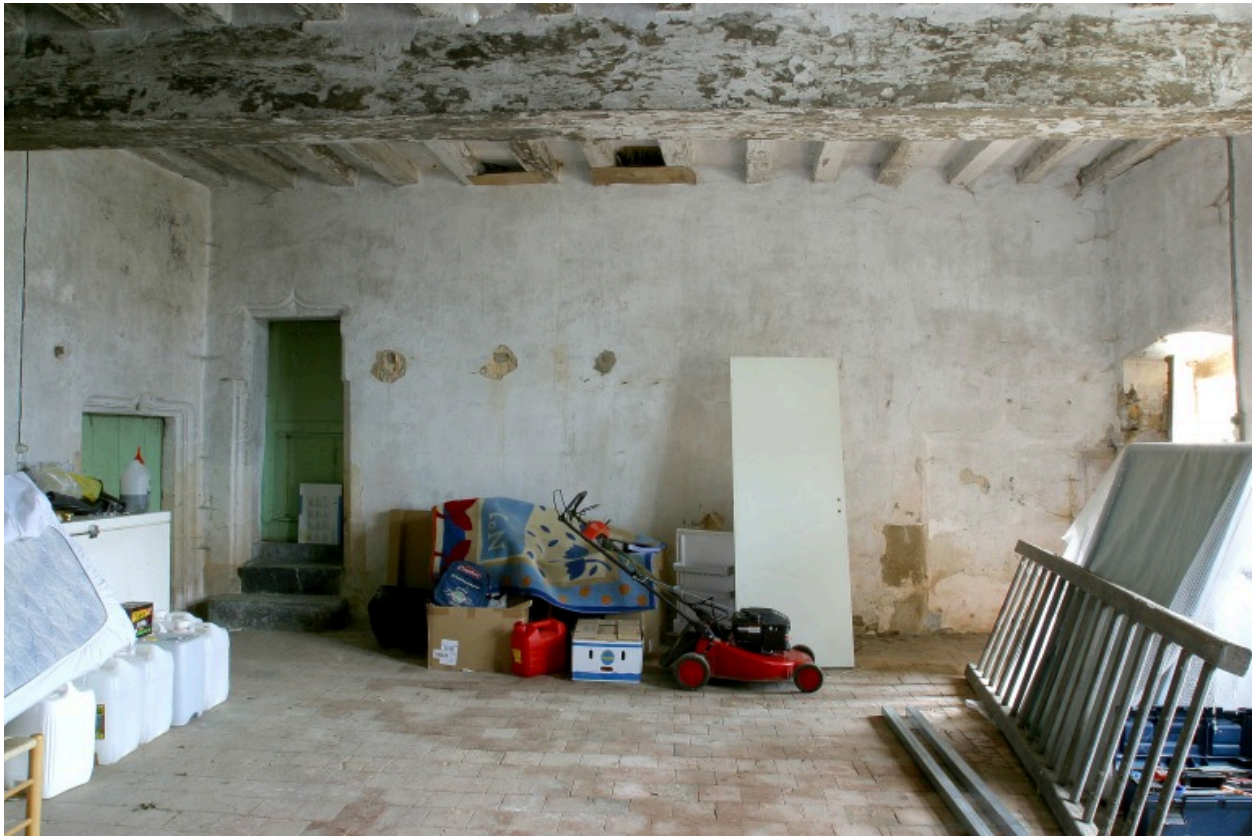
Rez-de-chaussée. Grande pièce : le mur est.
