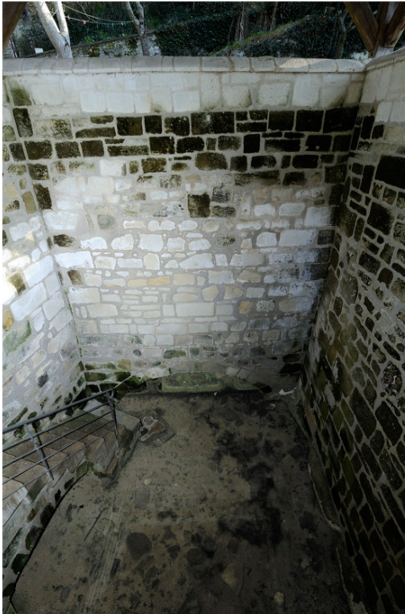
Parement intérieur de la fontaine
