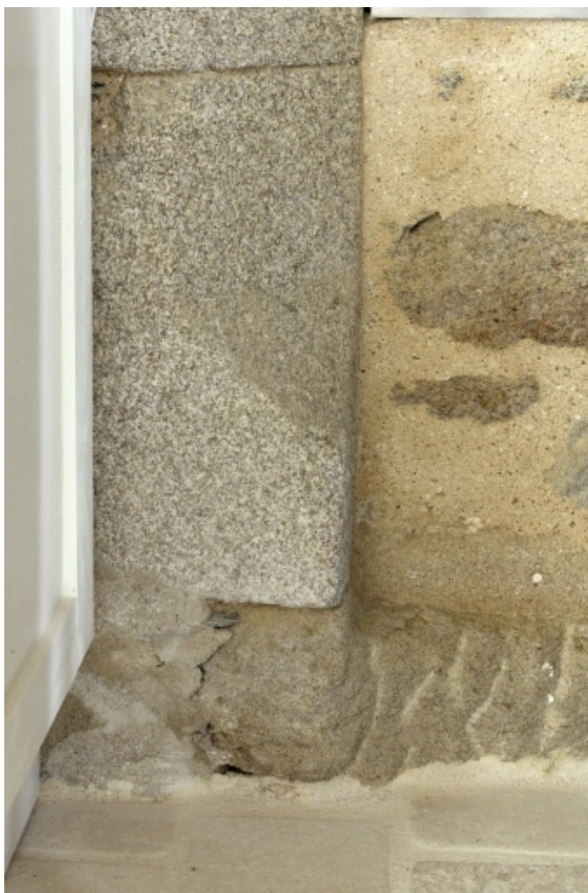
Cheminée sud au rez-de-chaussée, détail de la base.
