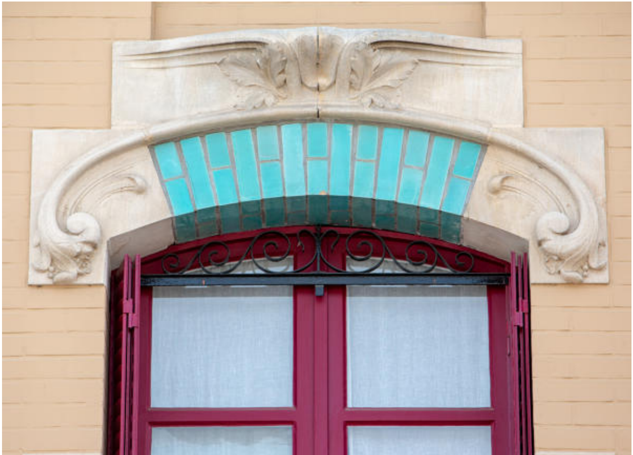
Vue de l'arc segmentaire de la fenêtre du premier étage, travée ouest.
