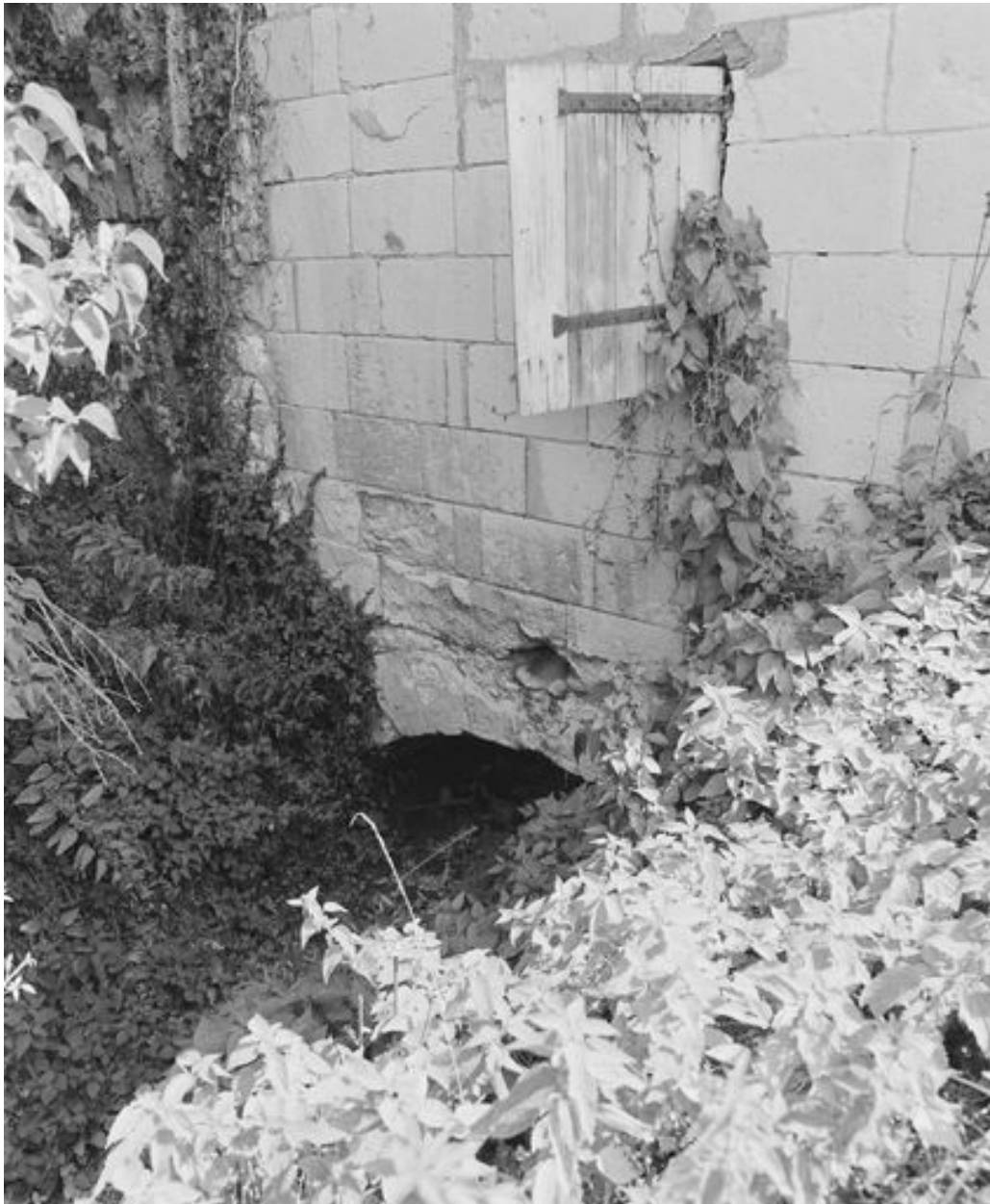
Le corps ouest de l'ancienne boucherie, enjambant le cours de l'Arceau.
