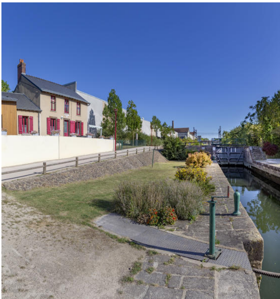
Vue du canal et de la maison de l'éclusier.
