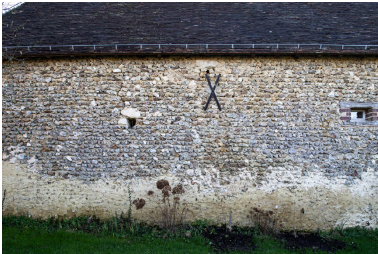
Ferme 1 : élévation postérieure du logis.
