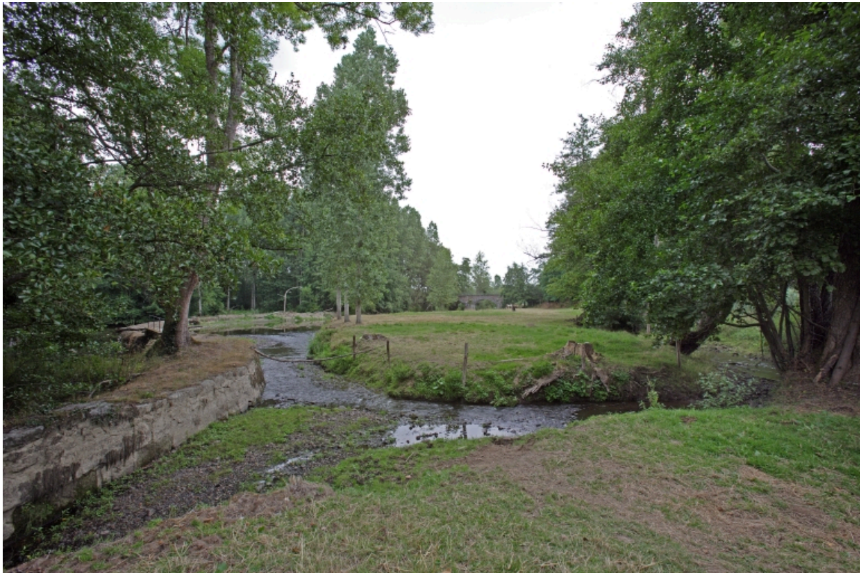
Le barrage sur la Mayenne, le canal d'alimentation du moulin et l'embouchure du ruisseau de Lassay vus depuis le moulin au sud-ouest.
