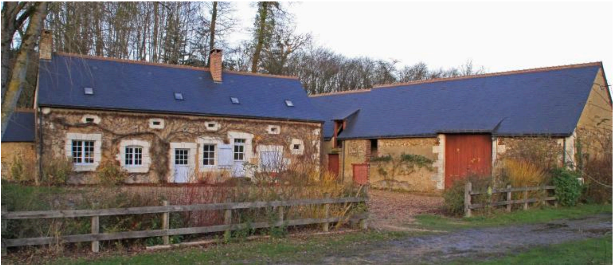
Maison et grange étable en L disjoint. La Ragée (1866).
