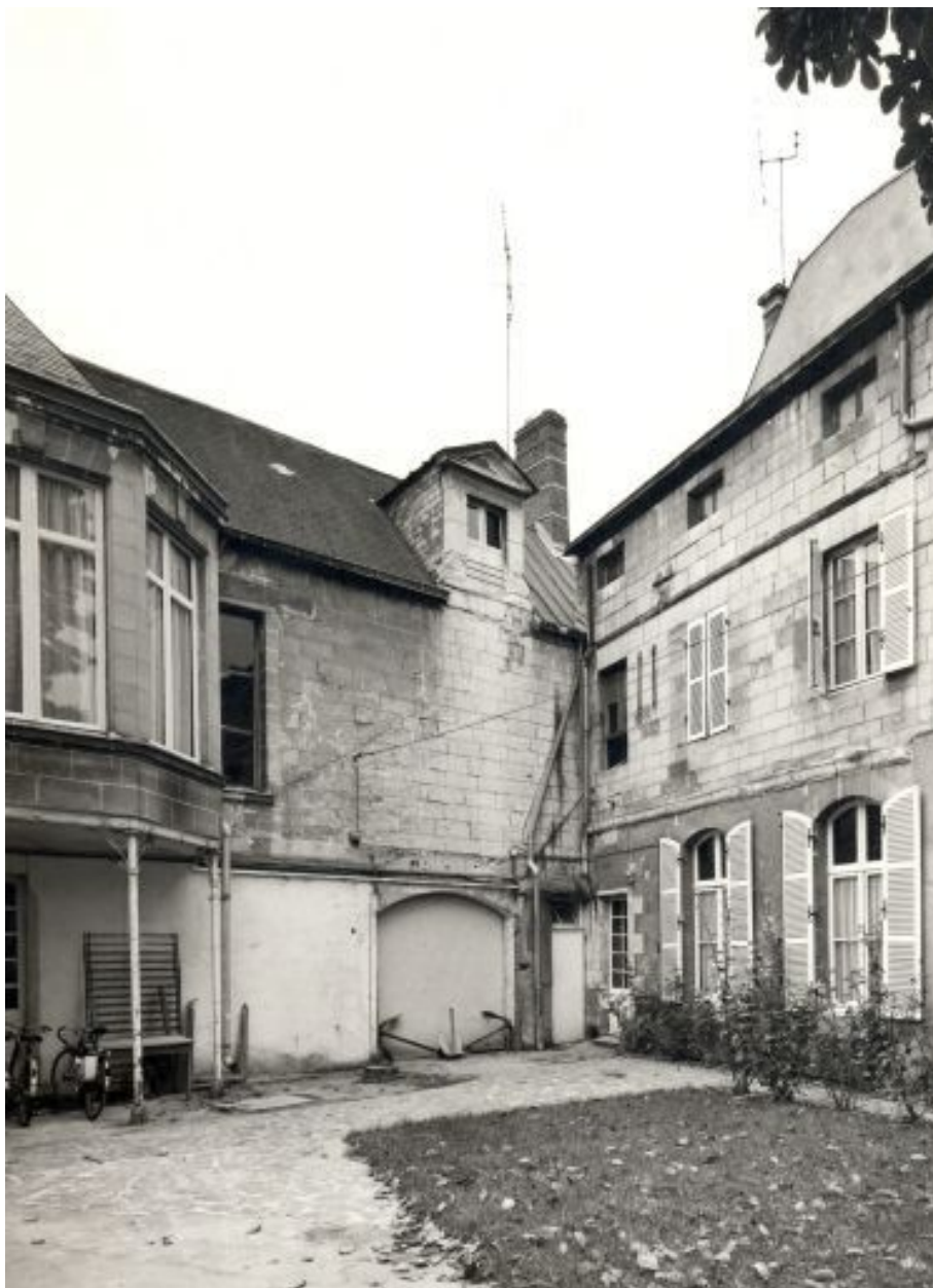
Façades sur cour, angle sud-ouest.
