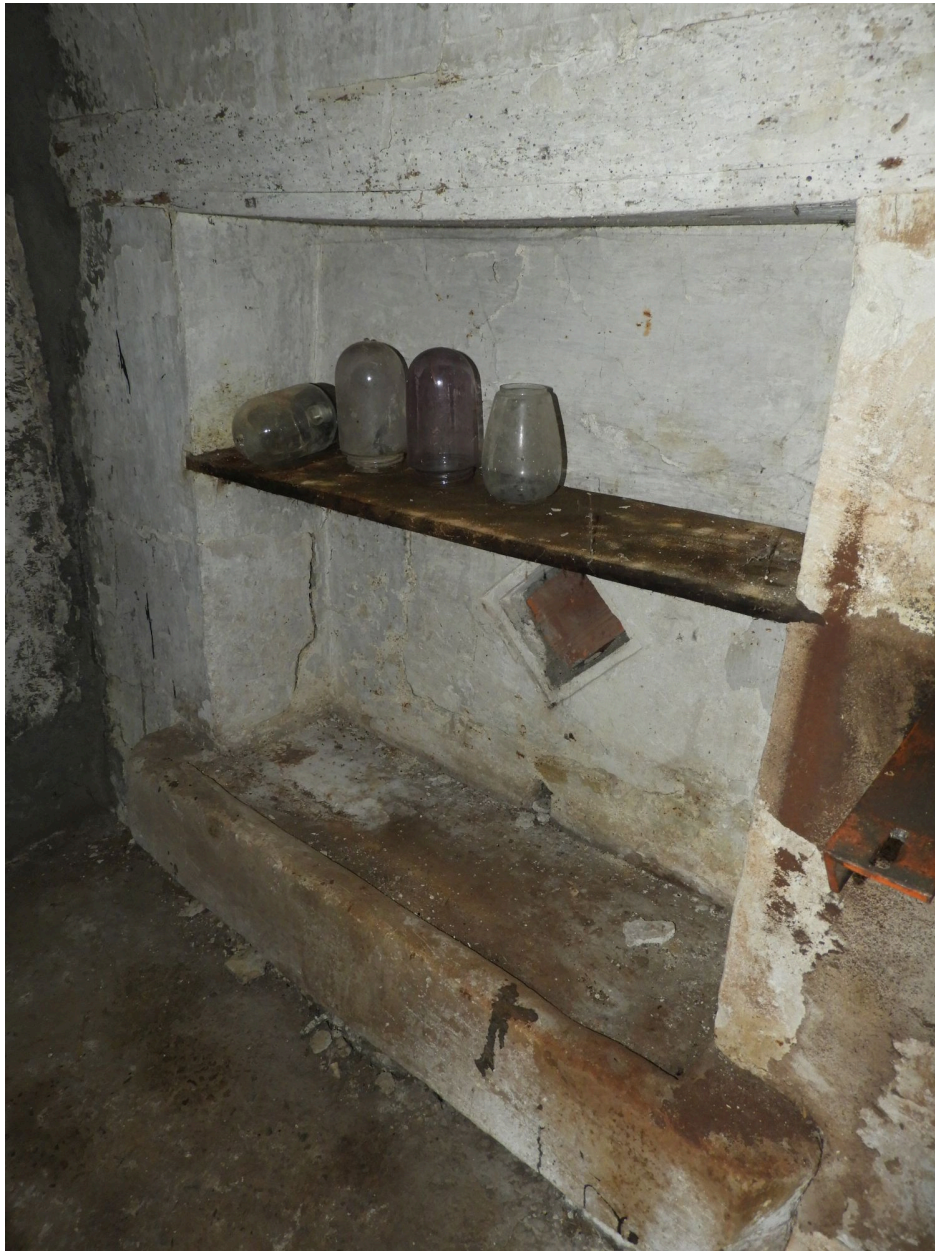
Placard aménagé dans l'épaisseur d'un mur.
