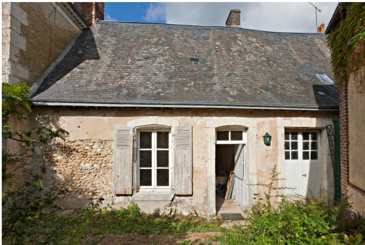
Façade antérieure sur cour.
