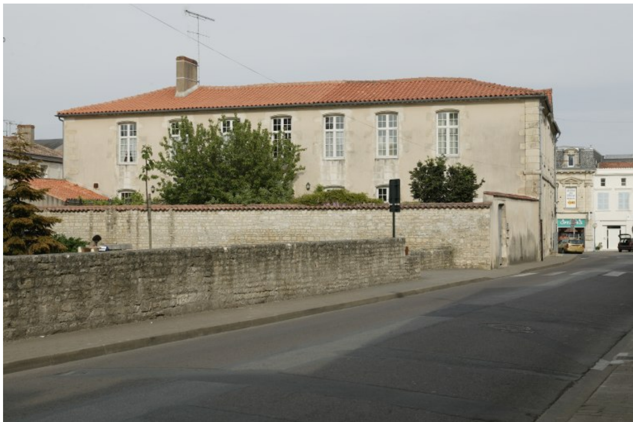
Façade ouest sur jardin.
