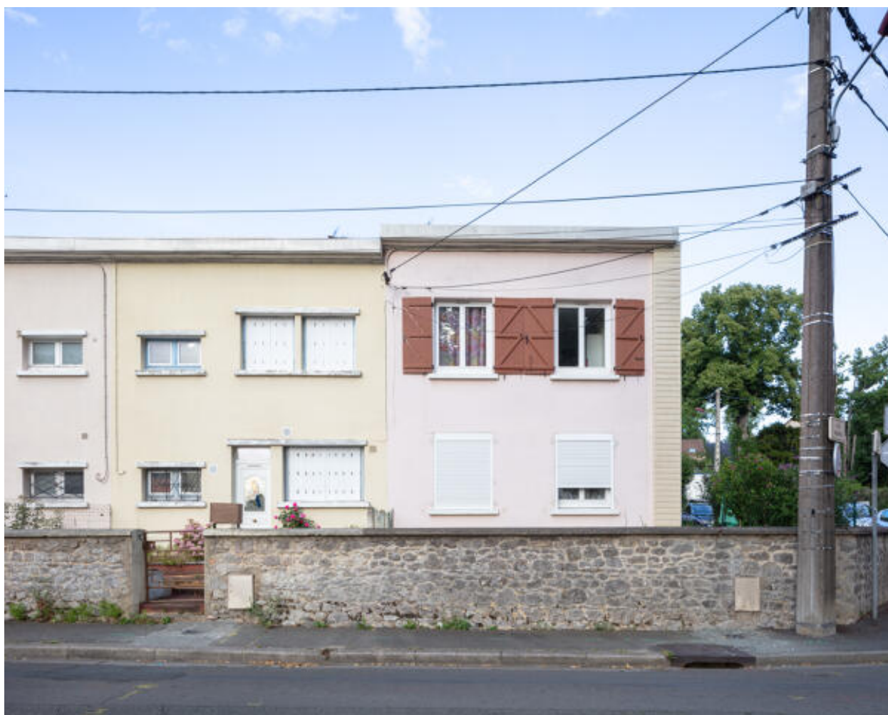
Vue des maisons à l'angle de la rue Le Nôtre et de la rue Besnier.
