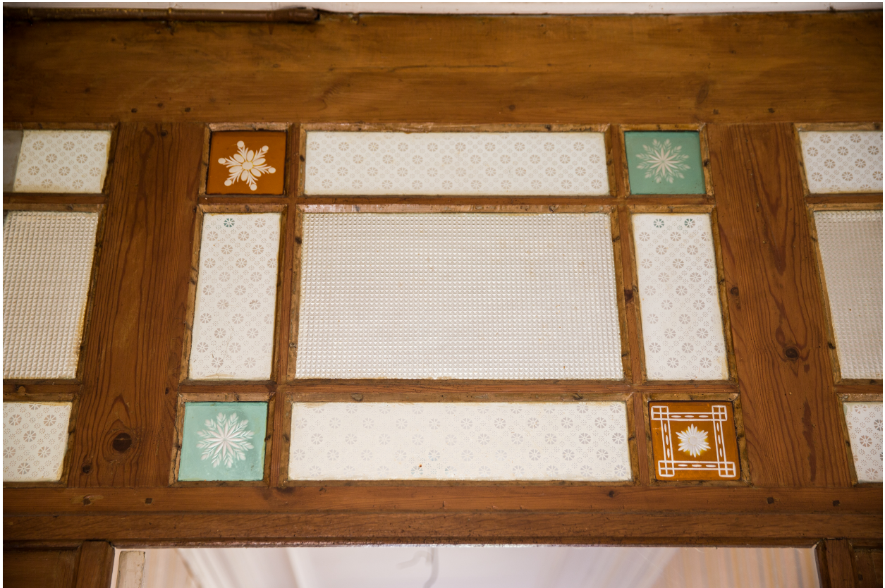
Un détail de la porte-fenêtre.
