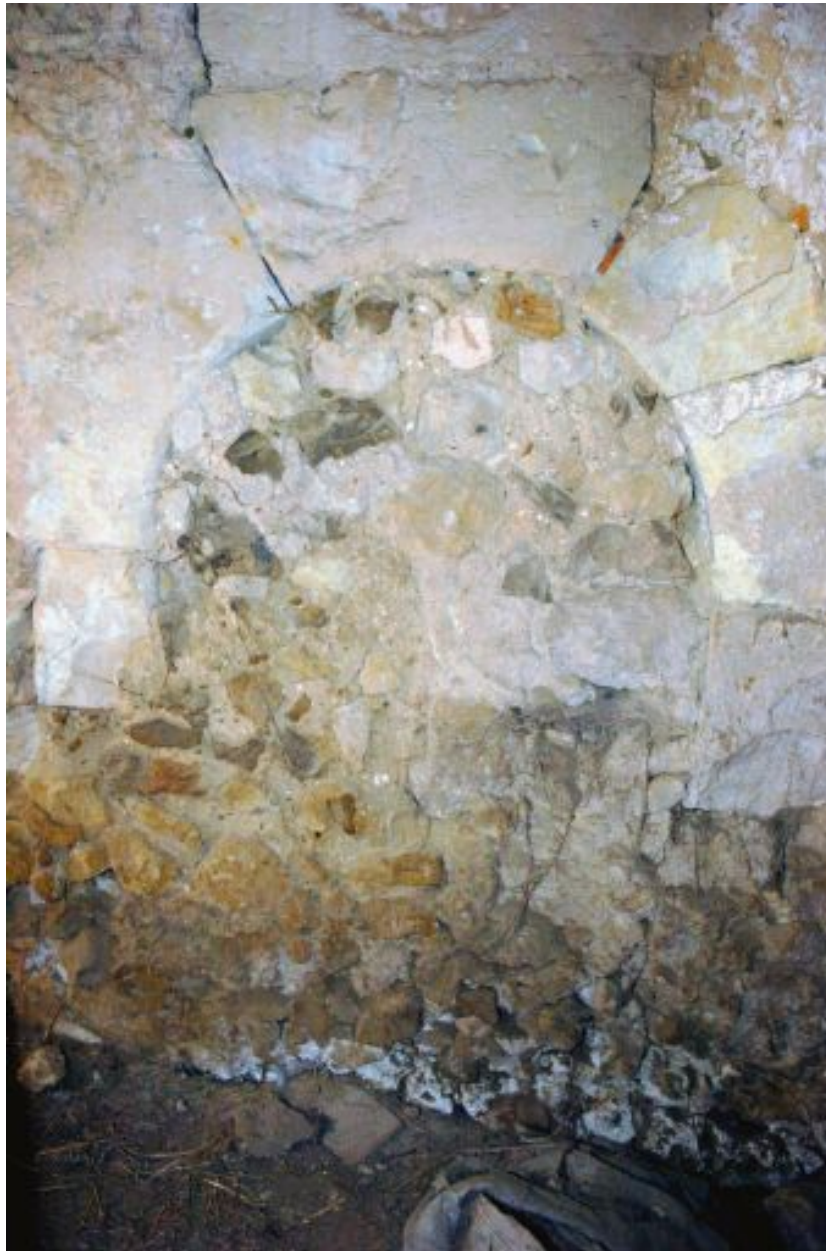
Porte plein cintre à l'entrée de la vis d'escalier.
