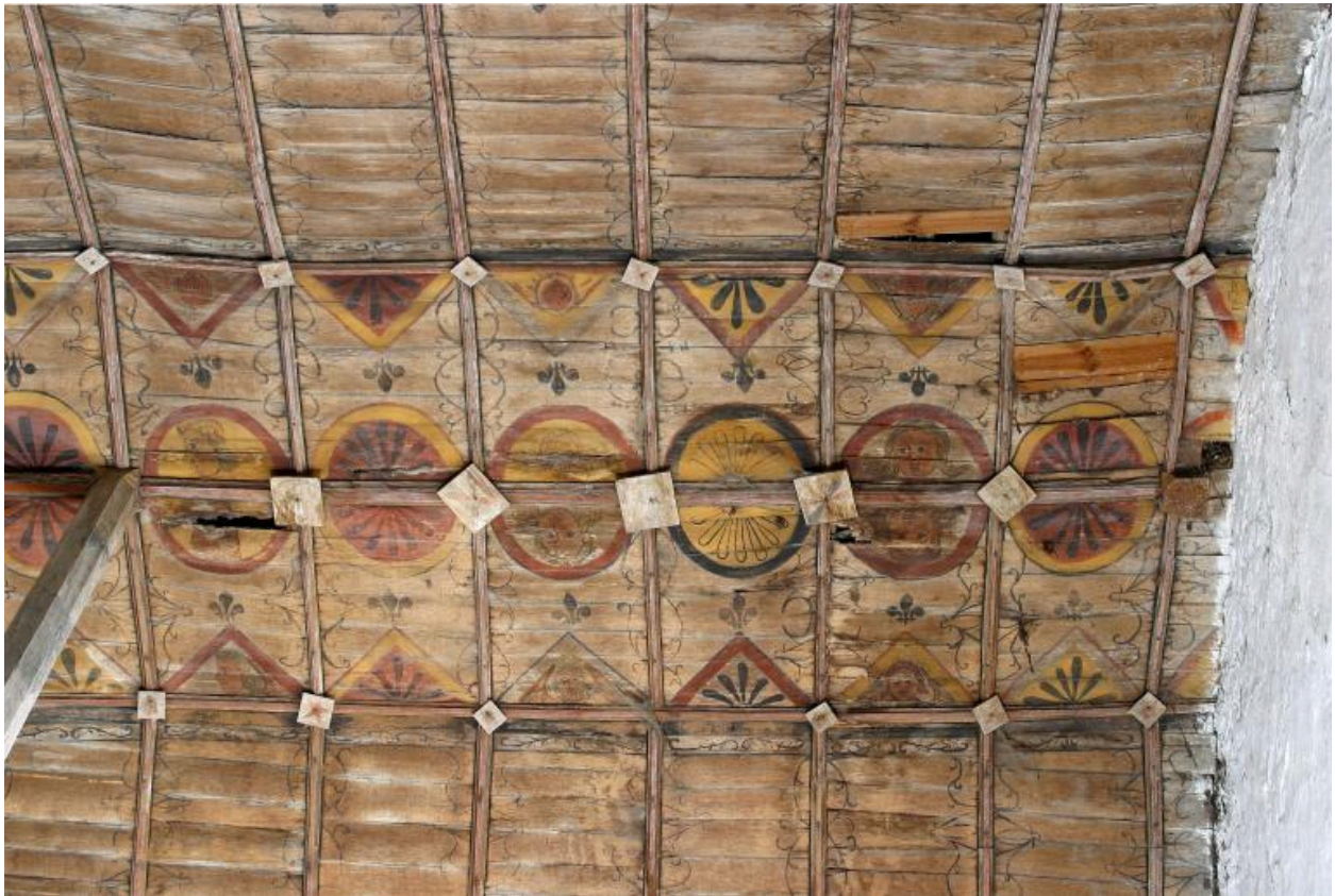
Nef, voûte, côté sud, première travée, registre de faîte : vue d'ensemble.
