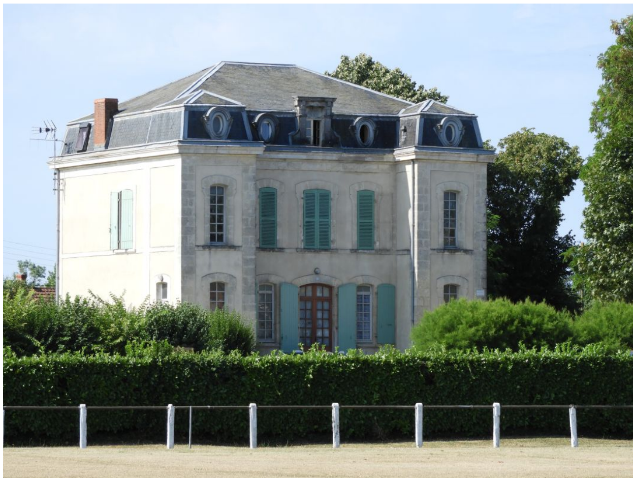
La gare vue depuis le nord-est.
