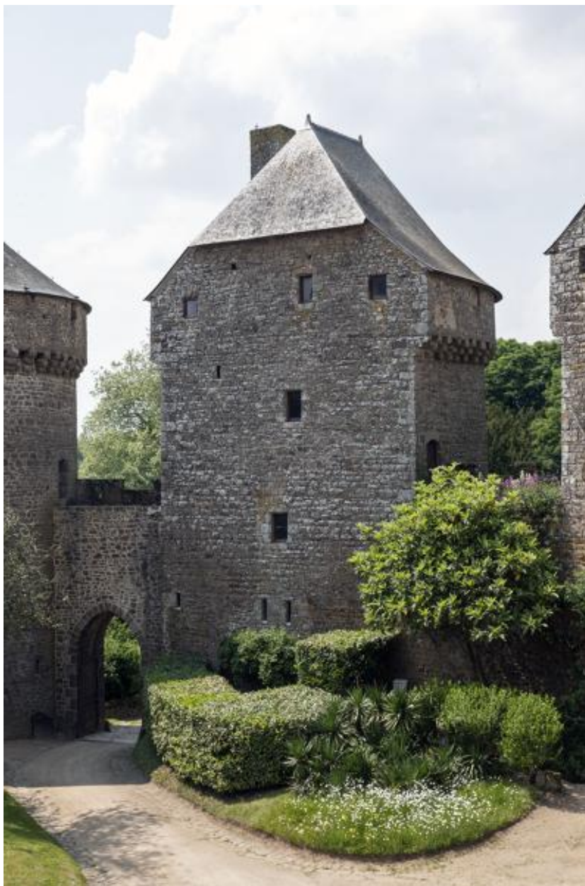
Tour 7, vue depuis la cour.
