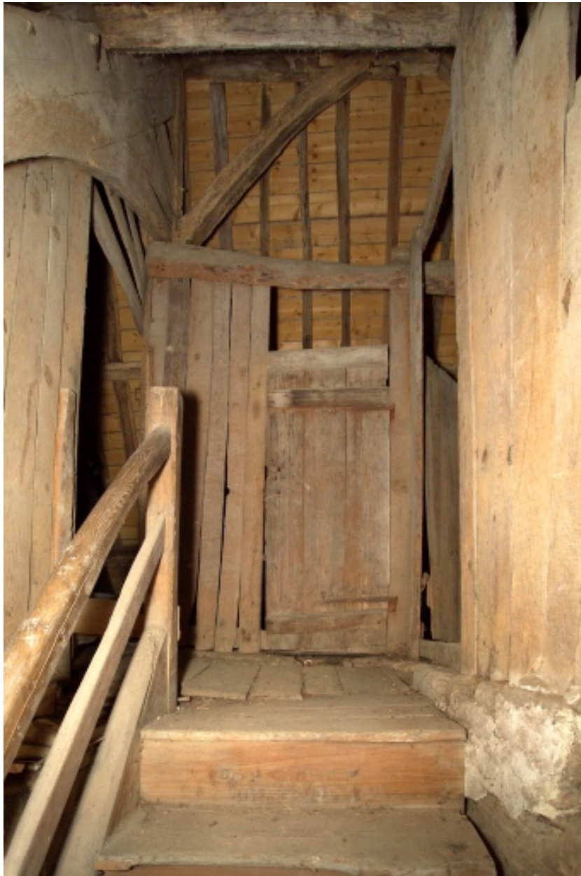
Vue du dégagement de l'escalier dans le comble.
