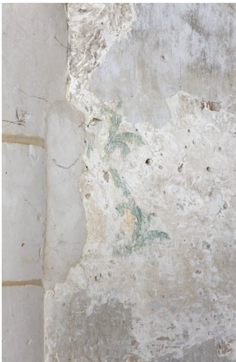
Rez-de-chaussée, salle, mur latéral : détail d'un rinceau vert peint à droite de la cheminée et appartenant au premier décor.
