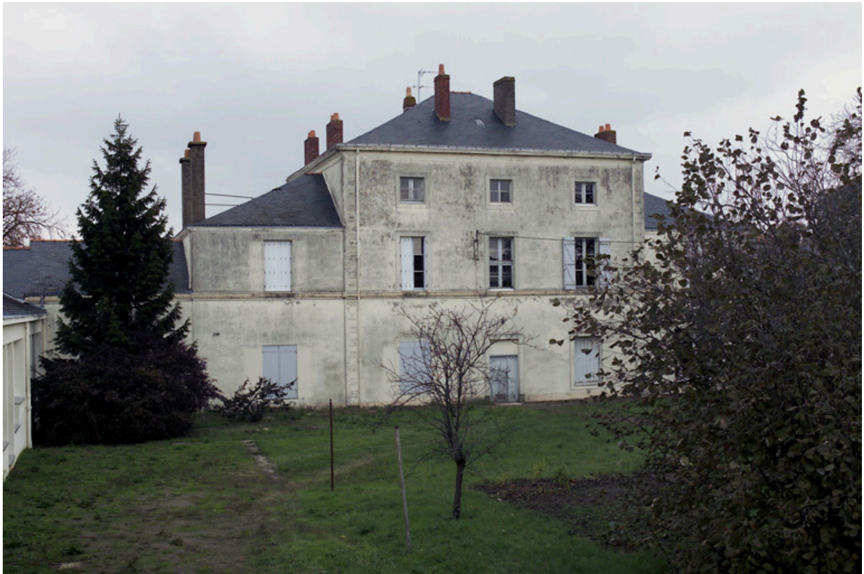
Vue de l'ancien collège depuis la rue Pronzat.
