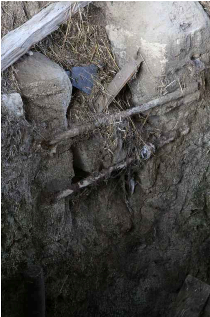
Le logis, la cave : vestige du soupirail du pignon.
