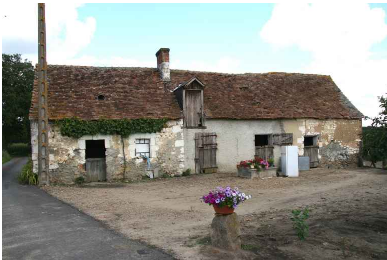
Façade antérieure sur cour.
