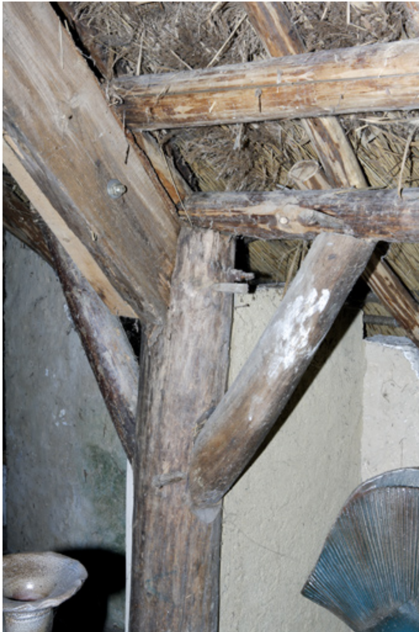
Étable sud. Détail d'un poteau de soutien de la charpente.
