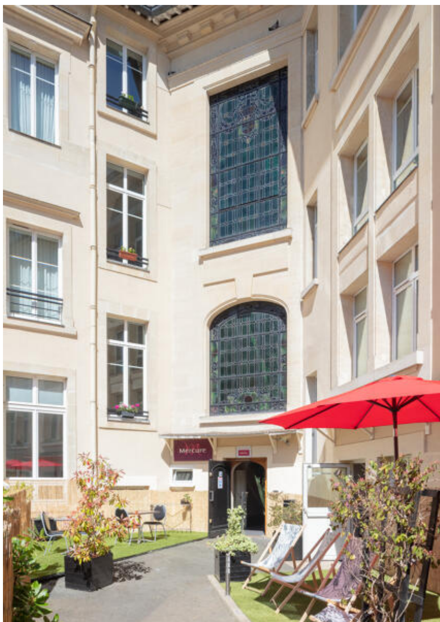
Vue des verrières de la cage d'escalier depuis la cour intérieure.
