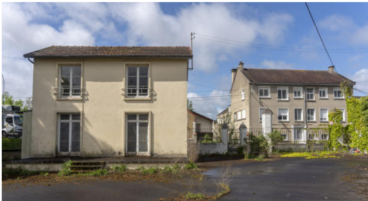
Logement du gardien, bâtiment G, et portail de l'usine textile.
