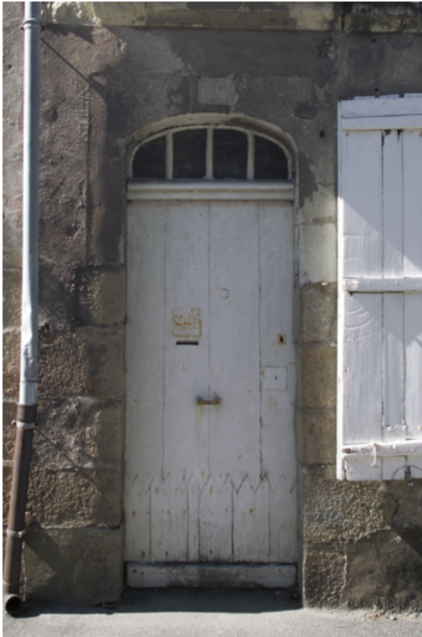
La façade sur la rue, détail de la porte d'entrée.
