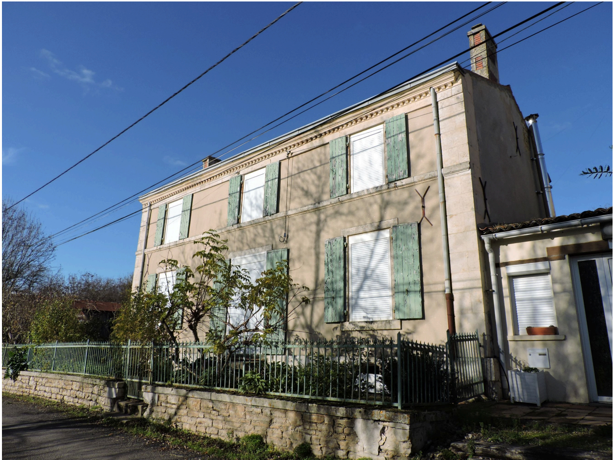
Le logis vu depuis le sud-est.
