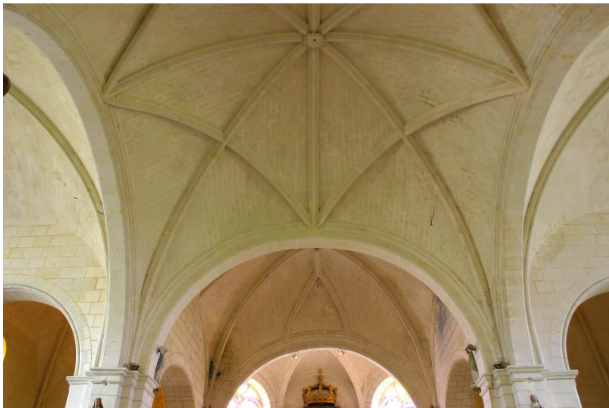
Voûte de la croisée du transept.
