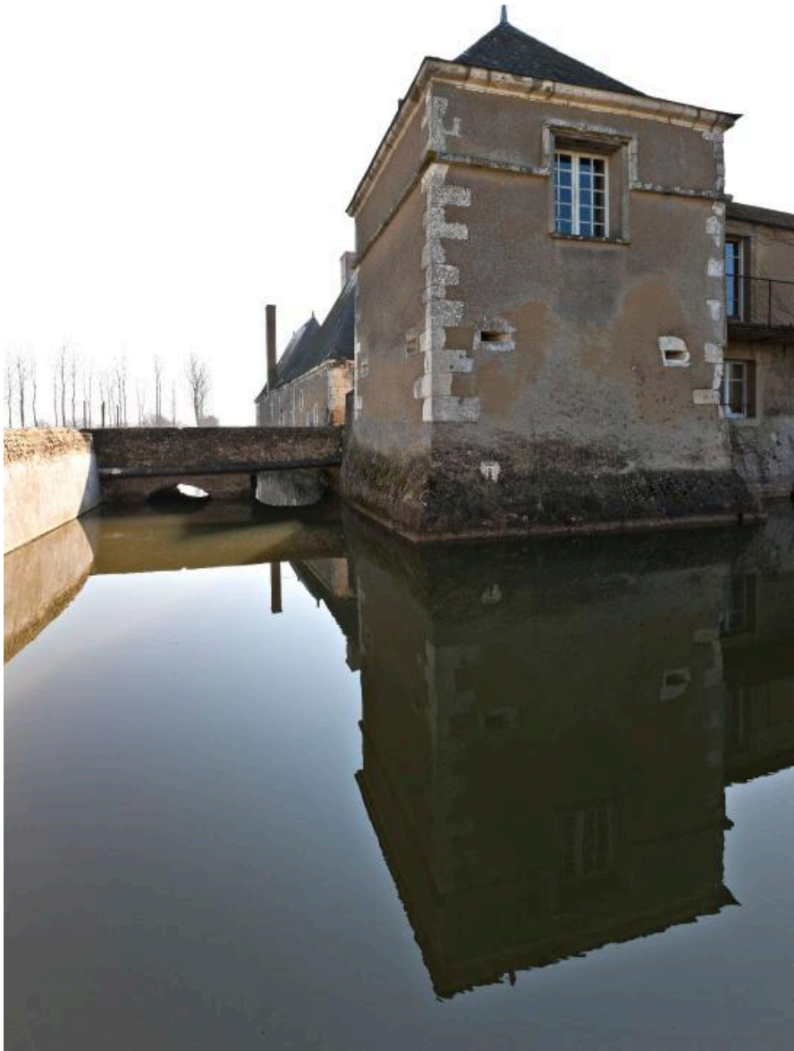
Vue depuis le nord-ouest : pont menant à la basse-cour.
