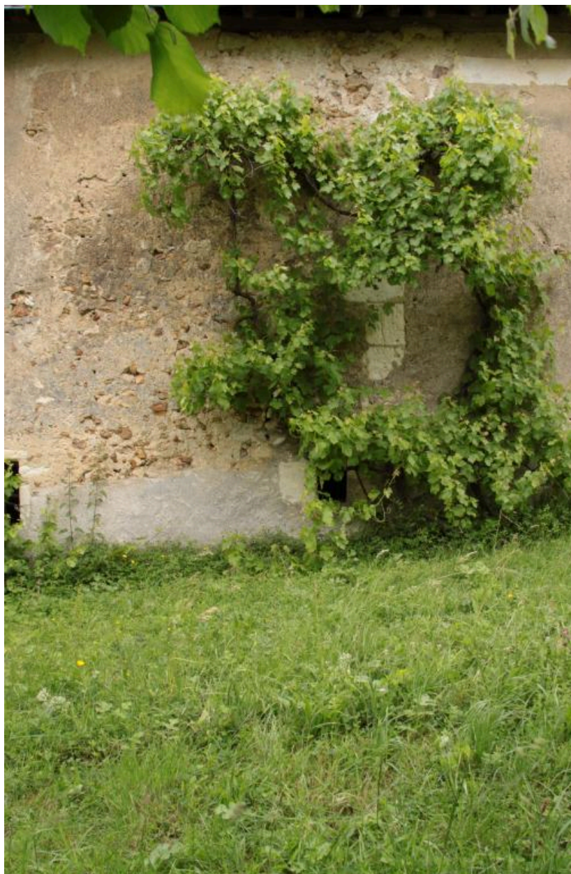
Logis, façade antérieure : détail de maçonnerie.
