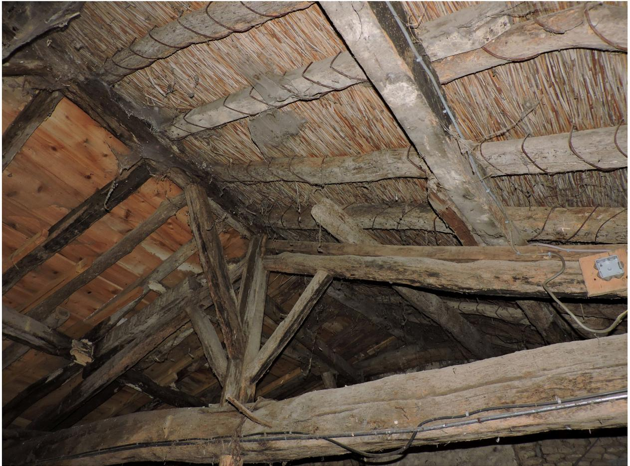
Charpente et couverture en roseaux du grenier au-dessus de la cuisine, à l'ouest du logis.
