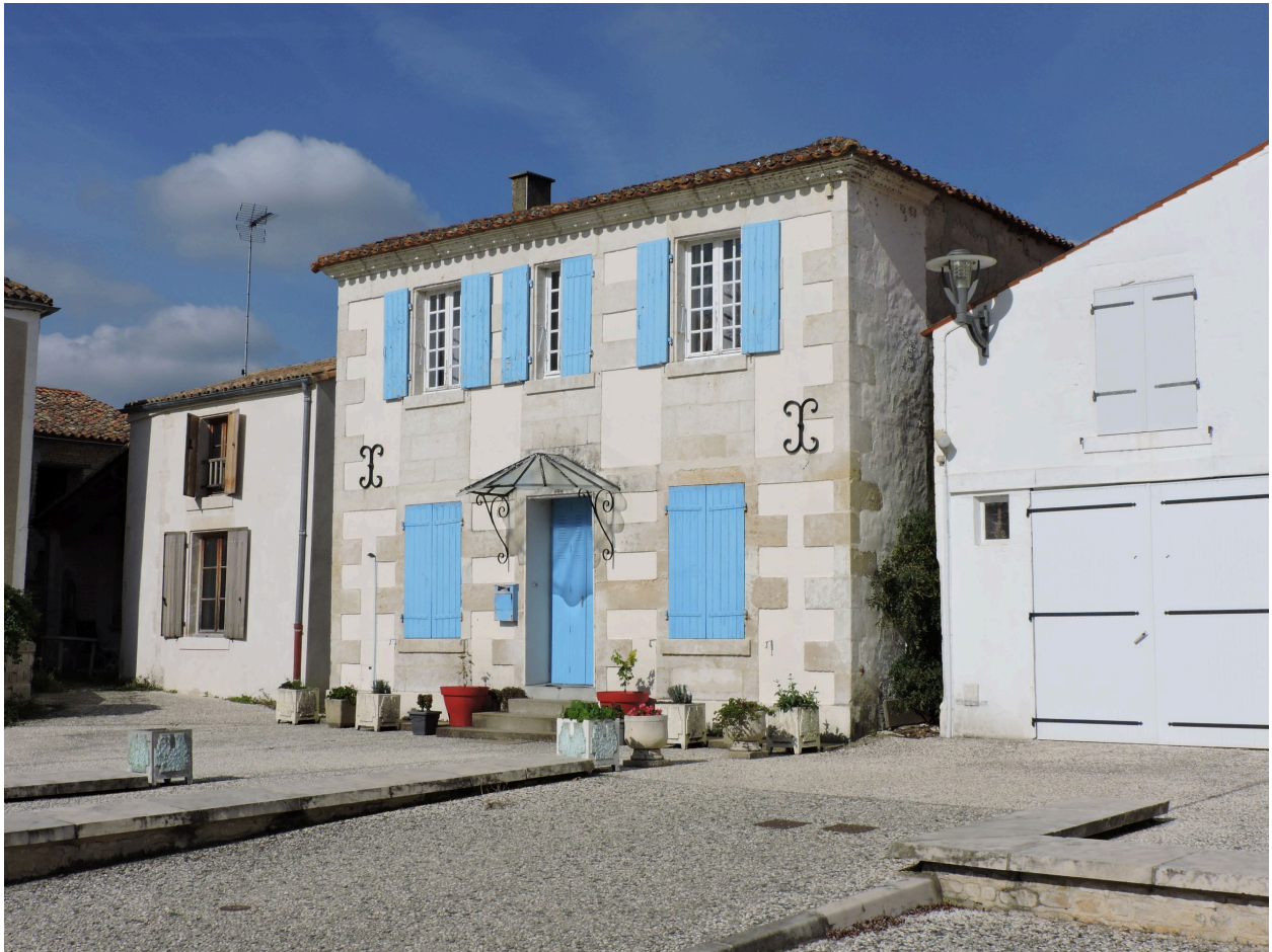
La maison vue depuis le sud-est.
