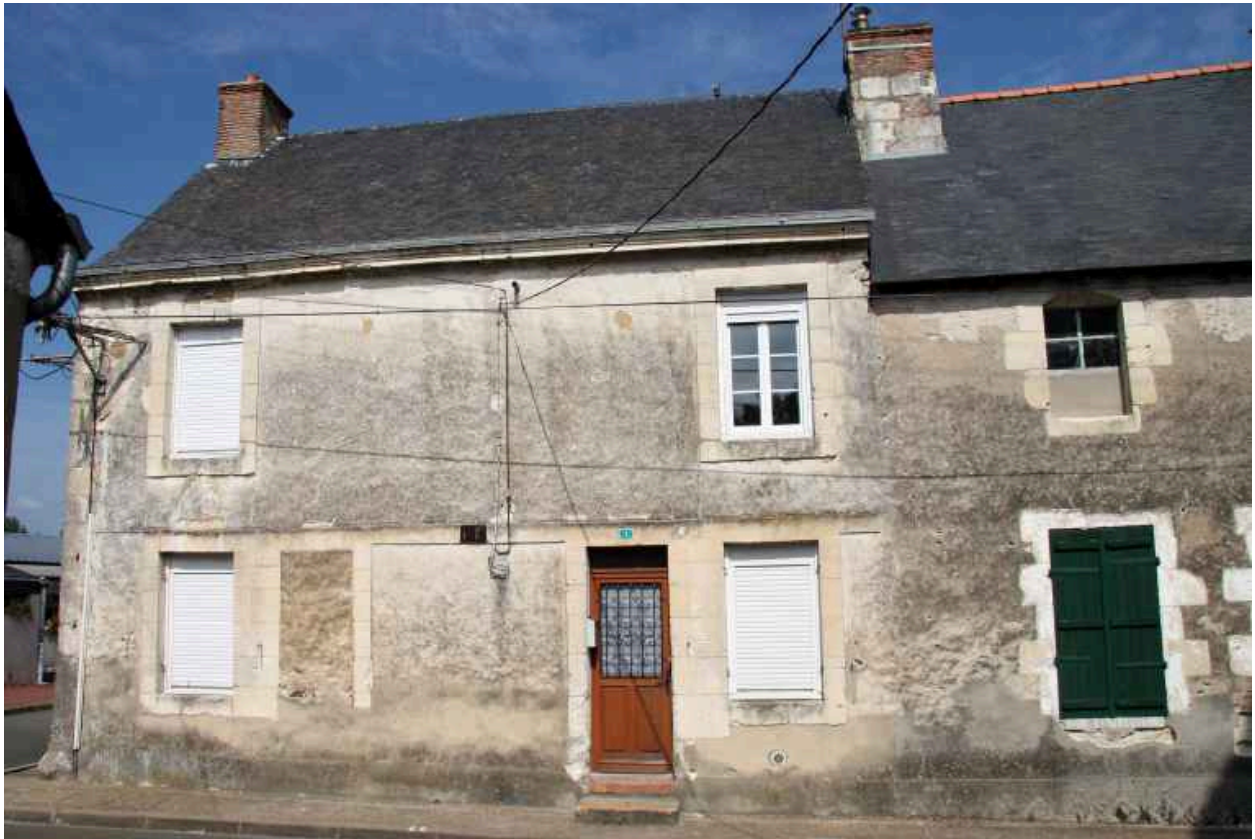
Îlot 1, place de l'Europe : première maison à étage.
