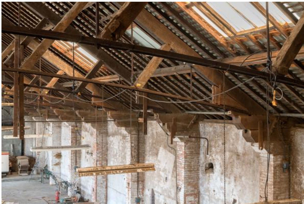
Vue depuis l'étage de l'usine sur la charpente mixte.
