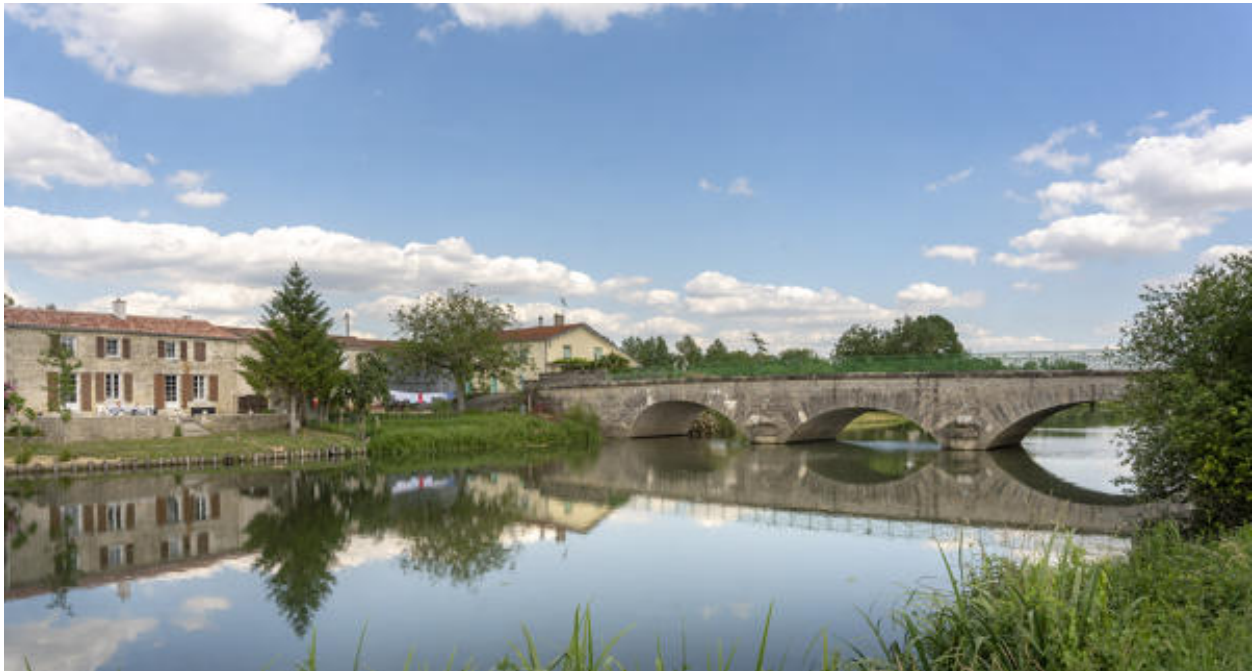
Le grand pont de la Croix des Mary vu depuis l'aval, à l'ouest.
