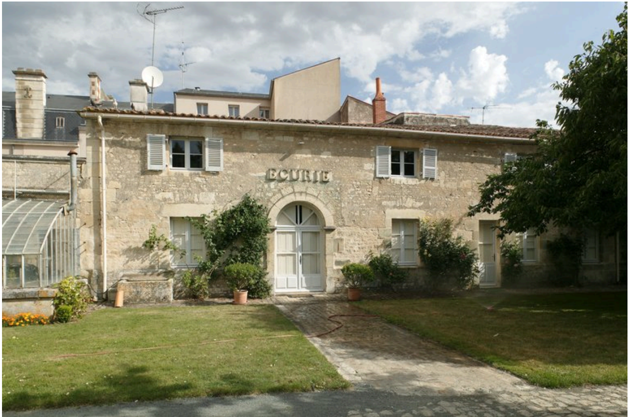
Bâtiment de communs est-ouest.
