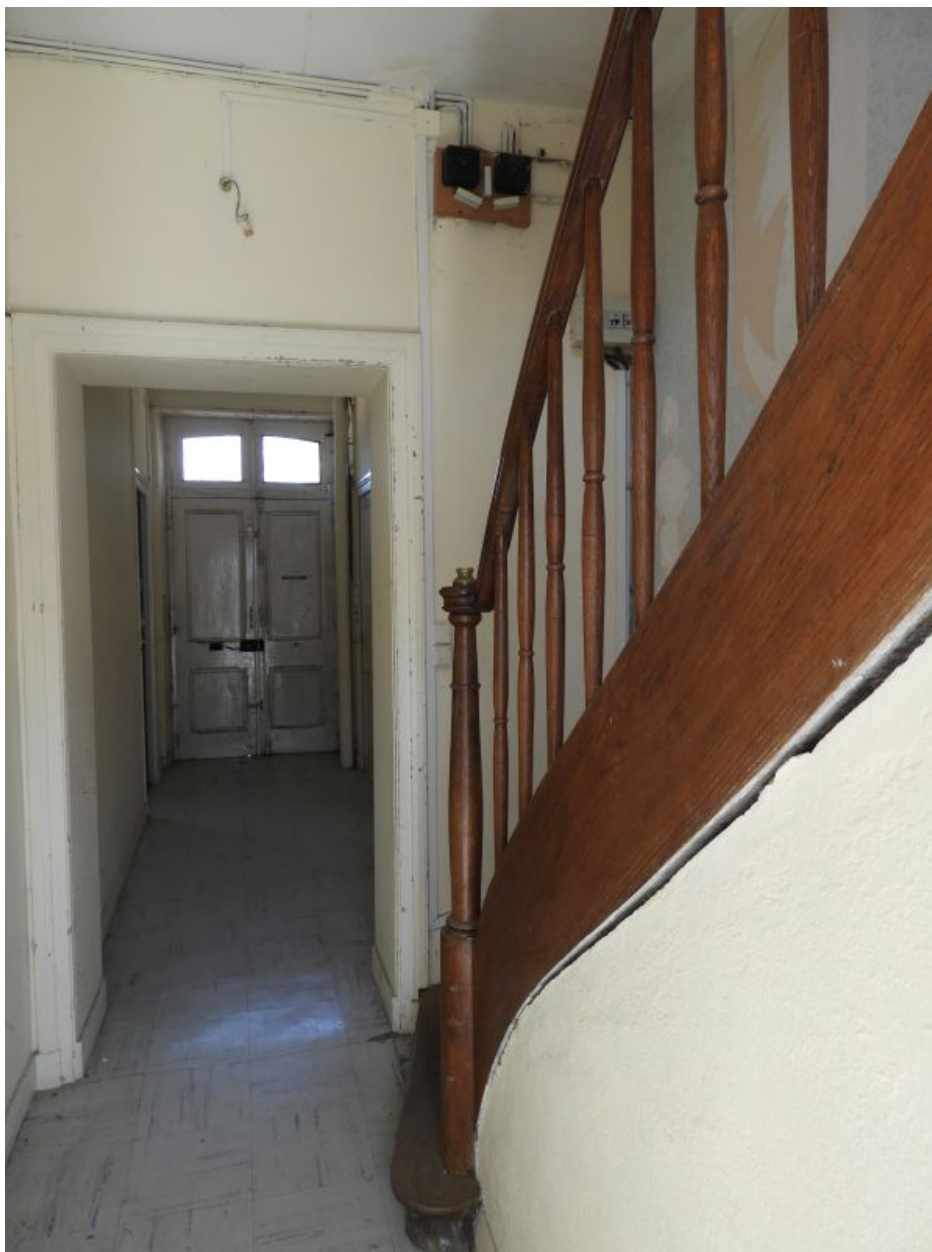
Vue intérieure d'un des logements de la fin du 19e siècle : couloir central et cage d'escalier.
