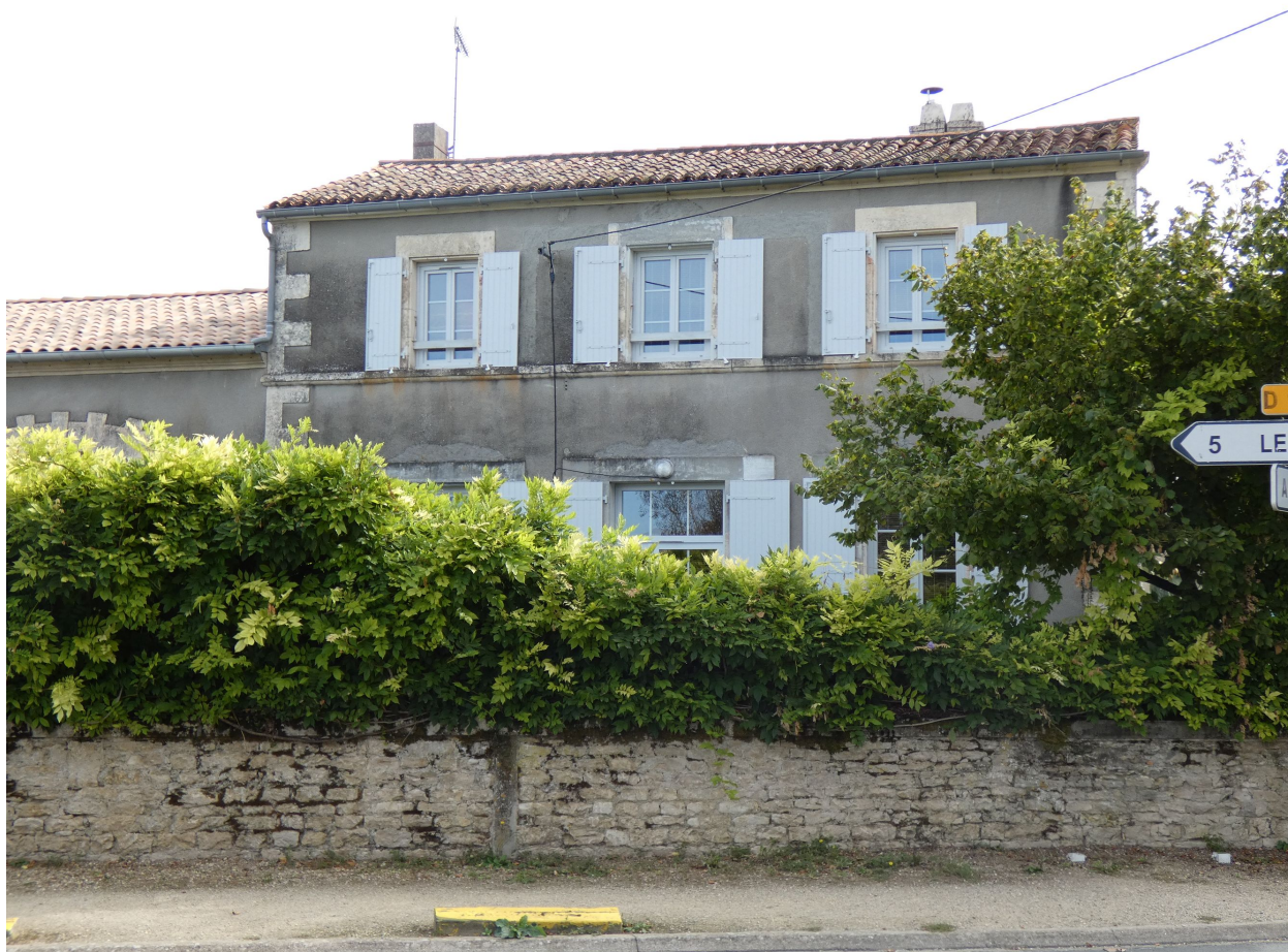
L'ancien logement de fonction vu depuis l'ouest.
