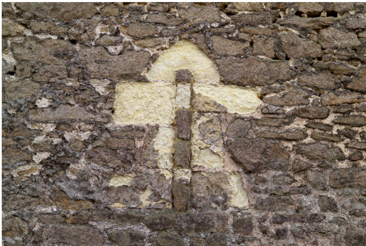
Fente de jour du mur nord.
