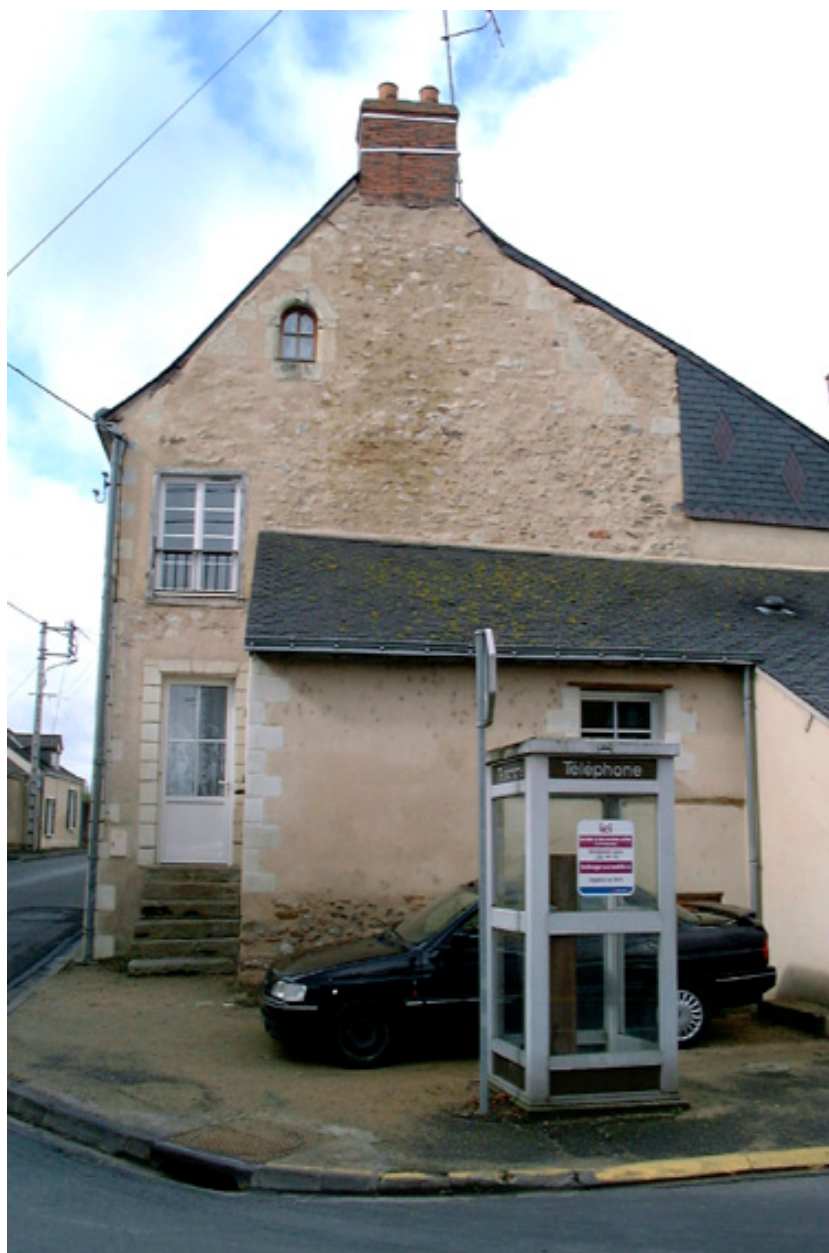
Vue du mur pignon nord.
